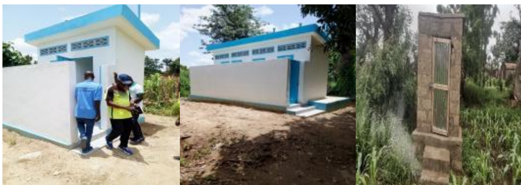
Photo10 : HSF et latrine familiale
