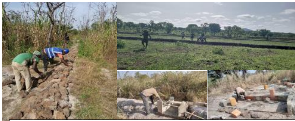
Photo 11 : Travaux d'aménagement des bas-fonds de type 1 dans Bassar
