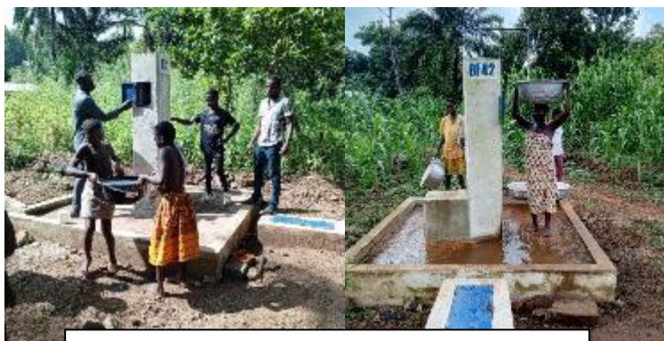
Photo 8: Mise en service des BF
