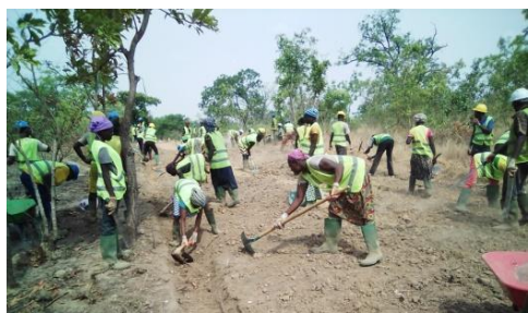
Réhabilitation de la piste à Outi
