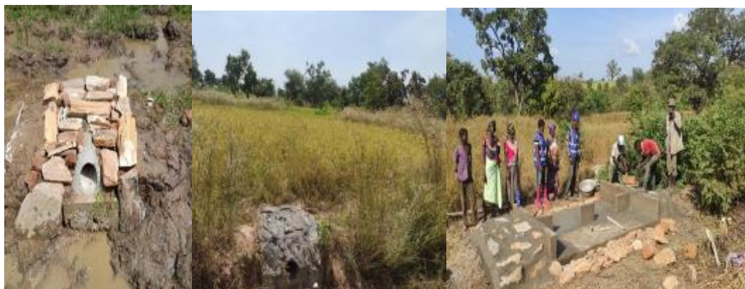
Construction des ouvrages de régulation d'eau : pertuis et déversoirs
