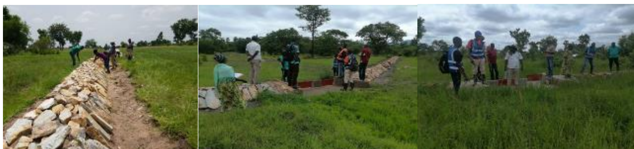
Finition des travaux et Mission de réception des travaux d'aménagement des bas-fonds de la phase 1
